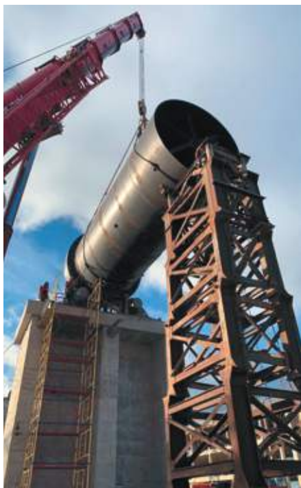
Монтаж элементов печи обжига
