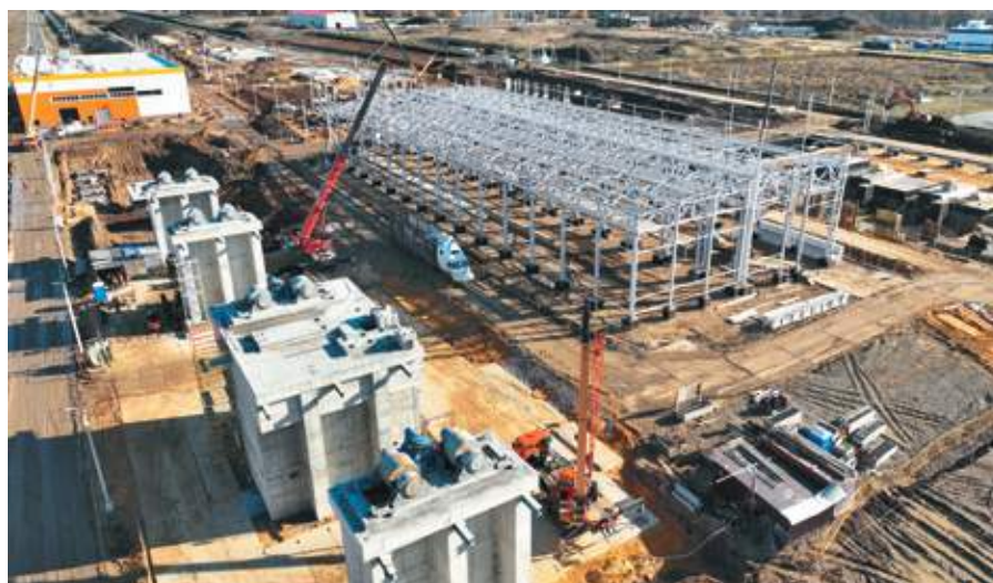
Вид на строительную площадку ООО «ЕВРАЗ Узловая»
