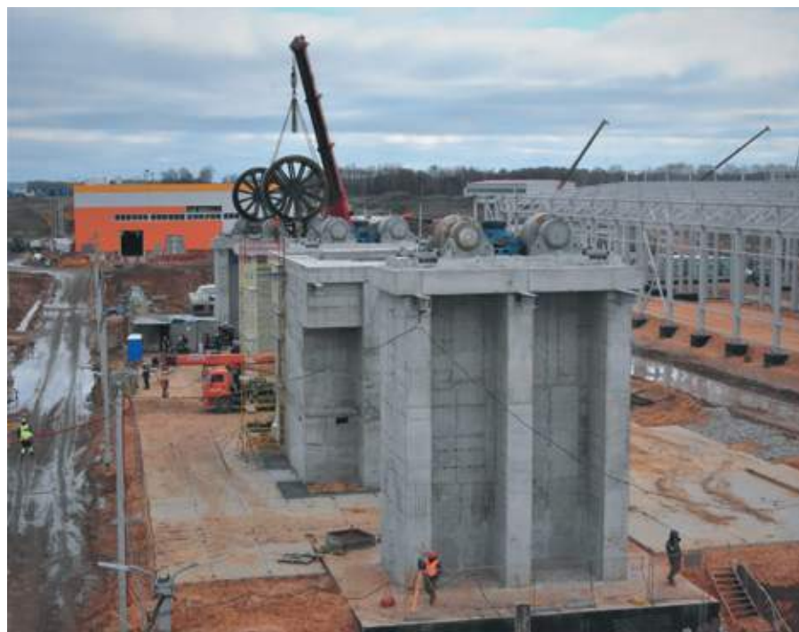
Бетонные опоры для обжиговой печи. Фото: Игорь Копытов
